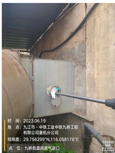
危废间废气进口采样
