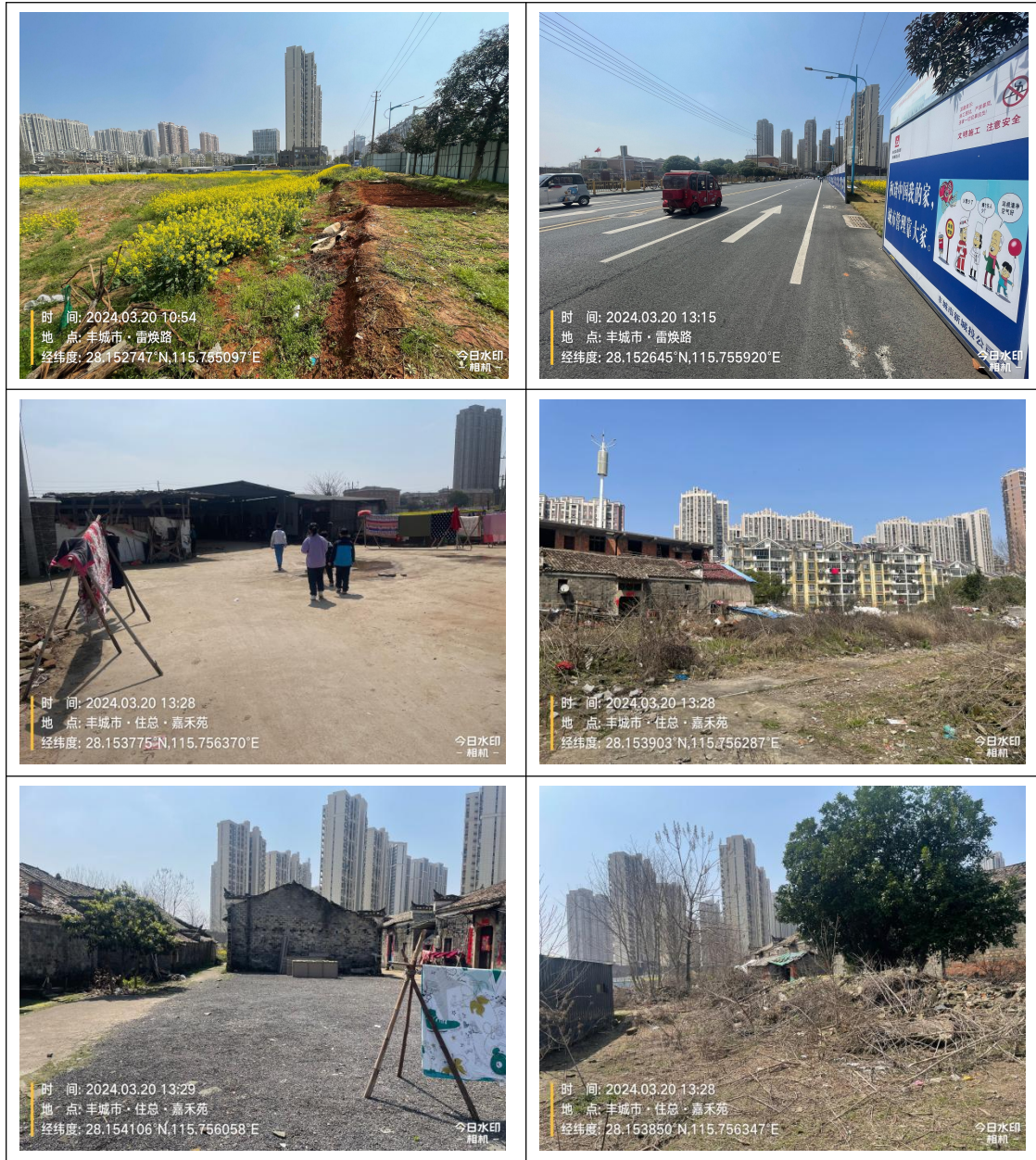
图 5.1-1 现场踏勘照片
